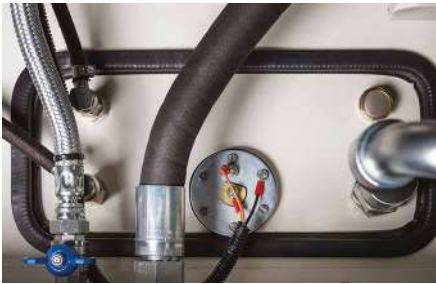
Depósito de combustible
