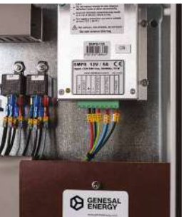
Mantenedor de nivel de batería de motor desde red externa
